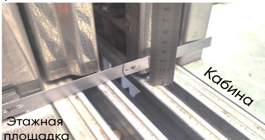
Рис. 5 Отклонение точной остановки. Кабина ниже этажной площадки. В таблицу записывается « -20 »
